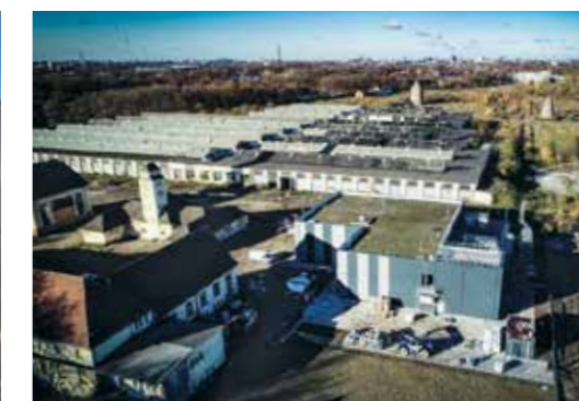
Ein extensiv begrüntes Dach dient der Senkung des CO2-Anteils und der Umgebungstemperatur im Sommer.
