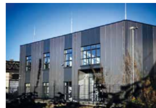
Das neue Rechenzentrum mit innovativer Wärmerückgewinnung setzt Maßstäbe in Sachen Energieeffizienz und Nachhaltigkeit.
