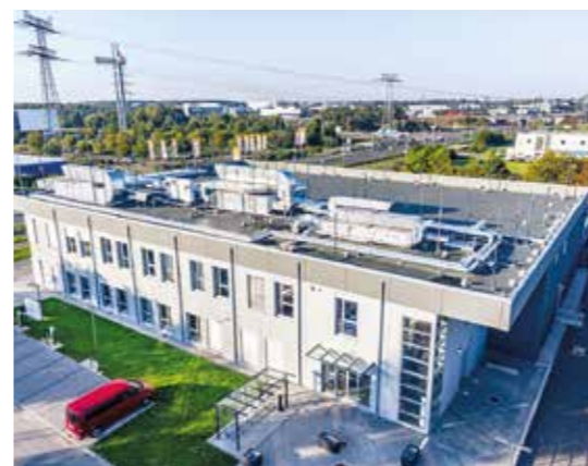
Nachhaltigkeit spielte bei der Realisierung des Hochleistungsrechenzentrums von envia TEL eine besondere Rolle.
