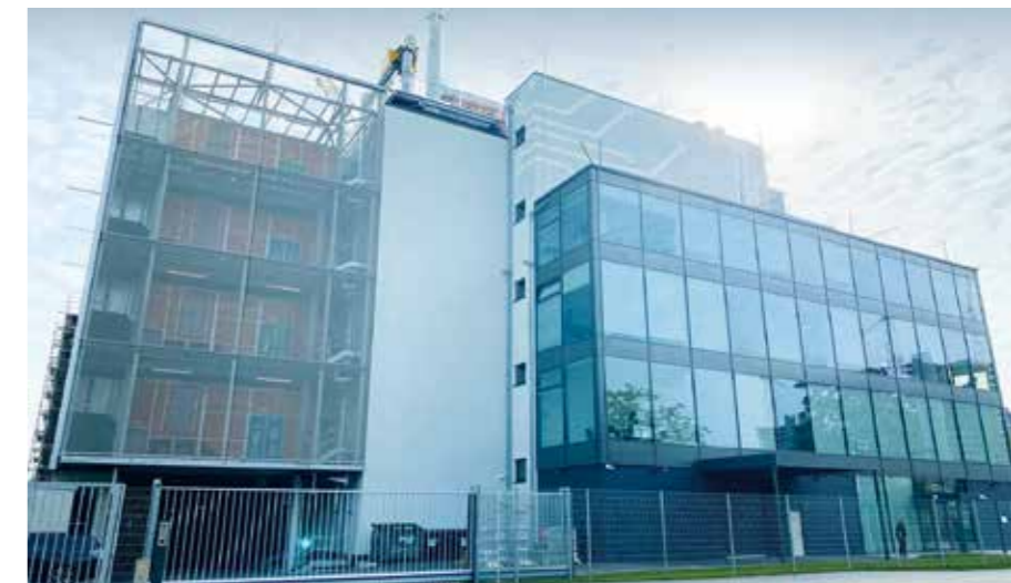
Der finale Meilenstein wurde gemeistert: Das neue Data Center der MAIN DC auf dem Gelände der EVO nahe des weltweit größten Internetknotens in Frankfurt ist fertiggestellt.
